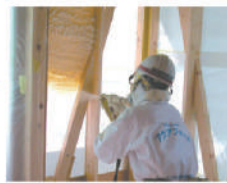
各部すき間なく吹付け
