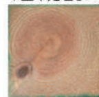
木材の表面のみ浅く浸透している
