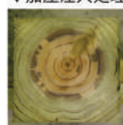
木材の内部まで深く浸透している
